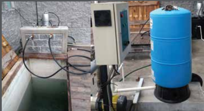
INSTALACIÓN HIDRÁULICA PARA PRUEBA DE PRESIÓN
