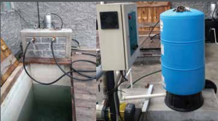
INSTALACIÓN HIDRÁULICA PARA PRUEBA DE PRESIÓN
